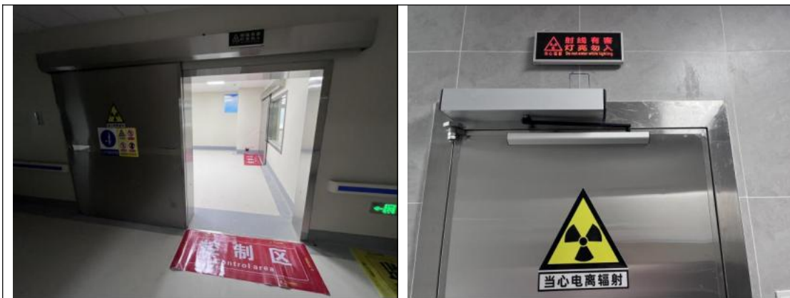
医技楼三楼 ERCP 室
